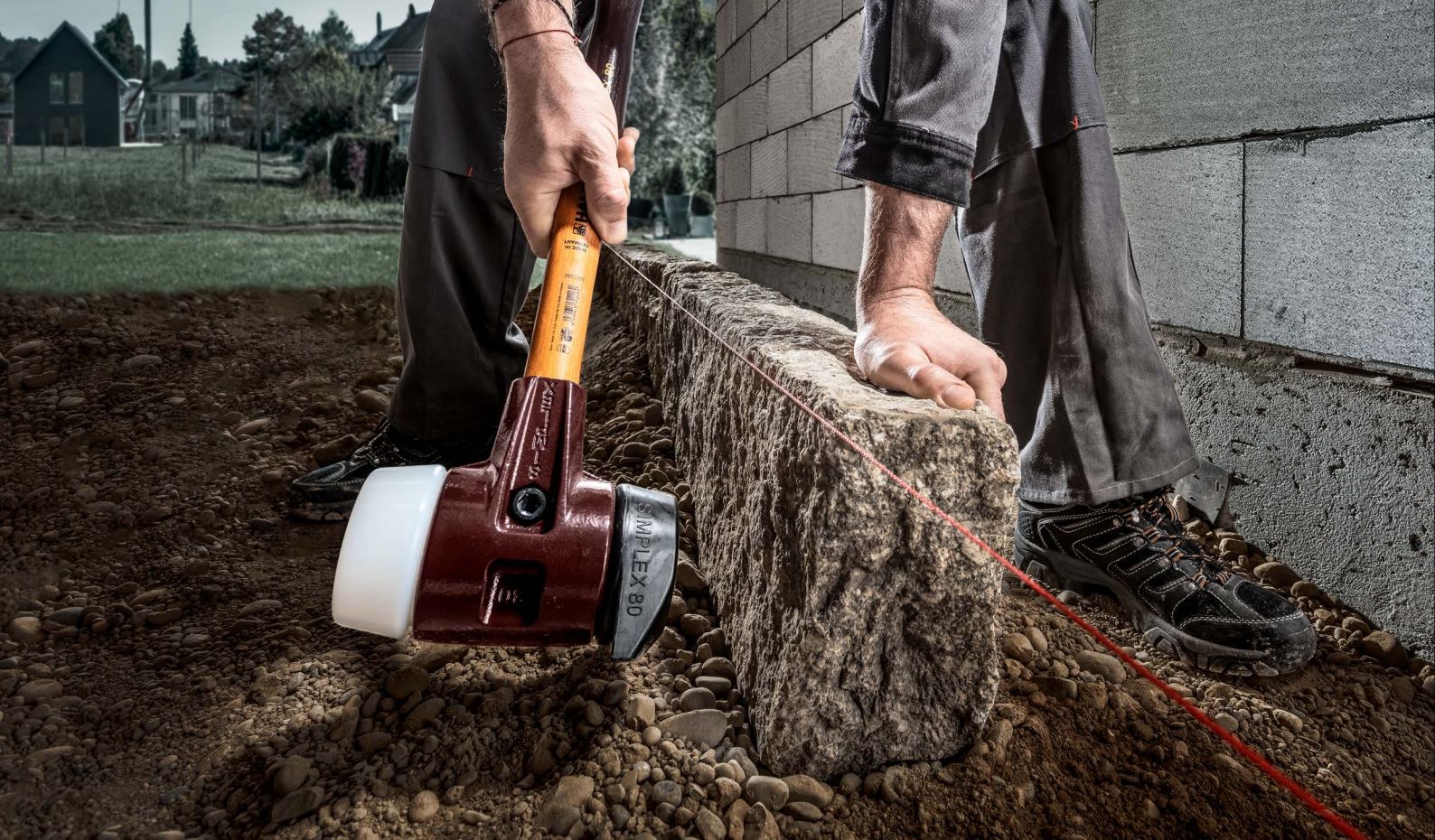
Der SIMPLEX-Schonhammer im Einsatz beim GaLaBau
